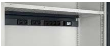
Application d'une rampe porte-prises électrique sur la partie inférieure de l' étagère-panneau perforé
